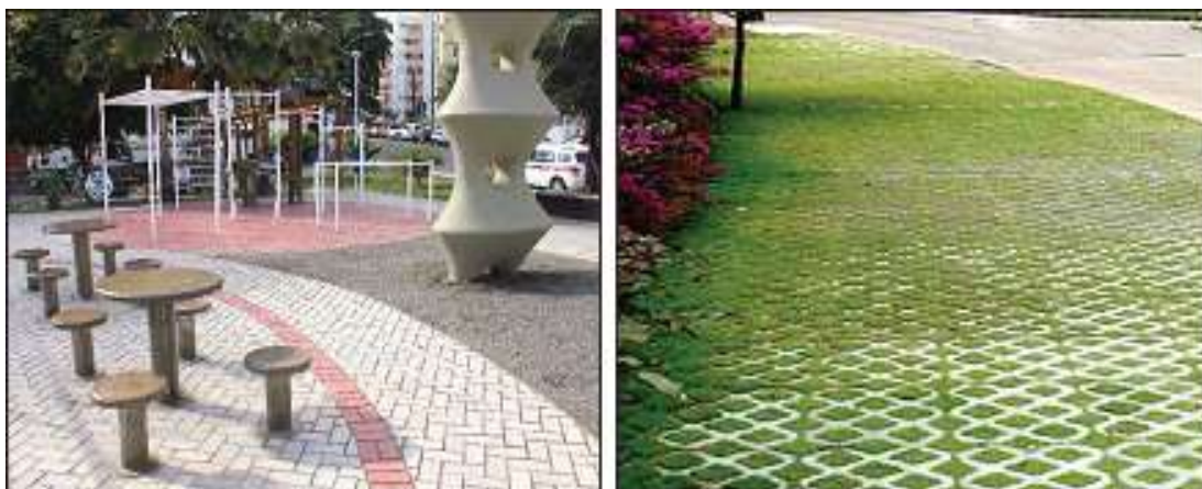
Figura 88: Pavimento poroso – Piso intertravado instalado em praça (Esquerda) e Concregrama instalado em passeio (Direita)
