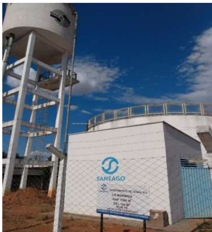
Figura 44: C.R. Maringá (Res. apoiado de 1.200 m 3 e Res. elevado de 100 m 3 ) (Fonte: DOMANI ENGENHARIA E OBRAS®, Set/2021)
