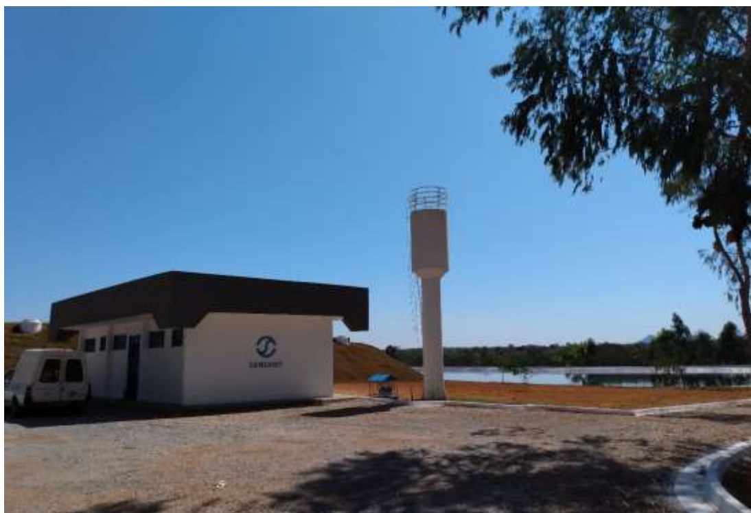
Figura 59: Estação de Tratamento de Esgoto (Casa de Controle)
