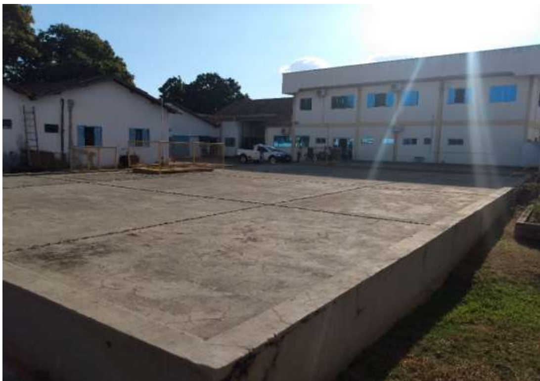
Figura 38: Tanque de Contato / ETA / Sede Administrativa
