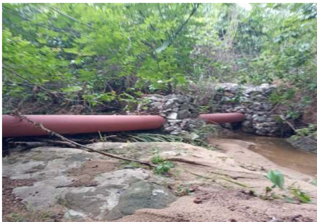
Figura 52: Travessia sobre o Córrego Funil – Sede de Porangatu (Fonte: Prefeitura Municipal de Porangatu, 2020)
