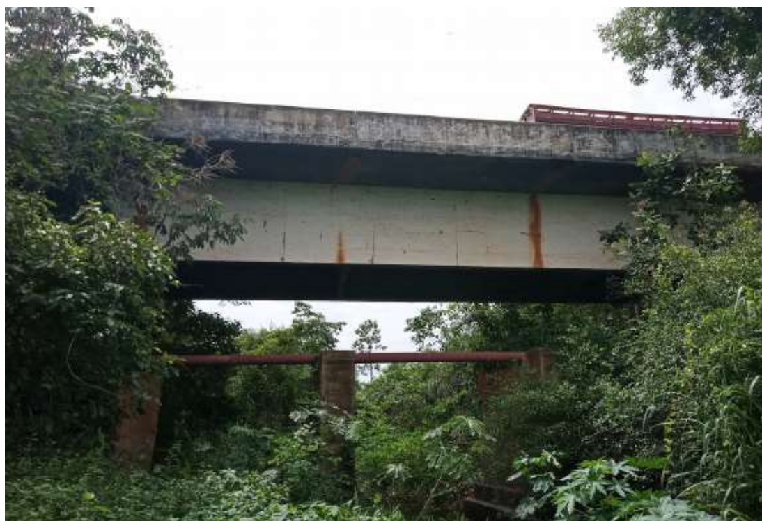
Figura 51: Travessia sobre o Córrego Raizama – Sede de Porangatu (Fonte: Prefeitura Municipal de Porangatu, 2020)
