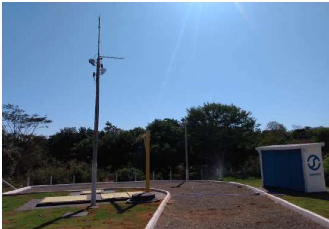
Figura 57: Estação Elevatória de Esgoto Norte (EEE Norte) (Fonte: DOMANI ENGENHARIA E OBRAS®, Set/2021)
