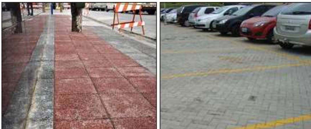
Figura 89: Pavimento poroso – piso intertravado instalado em passeio público (Esquerda) e em estacionamento (Direita) (Fonte: Imagens da Internet)
