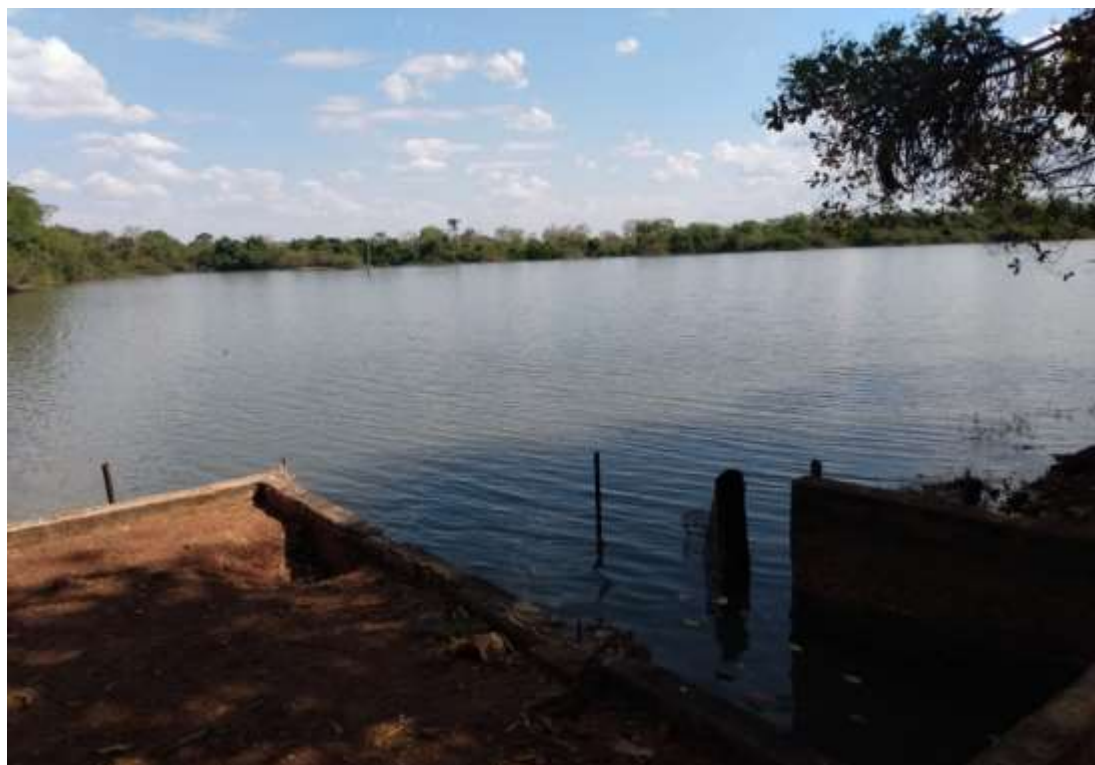
Figura 28: Barragem de nível localizada no Ribeirão Funil
