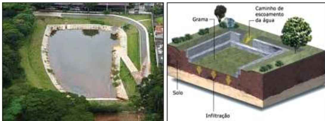
Figura 92: Bacia de detenção (Esquerda) e Reservatório em parque municipal (Direita)
