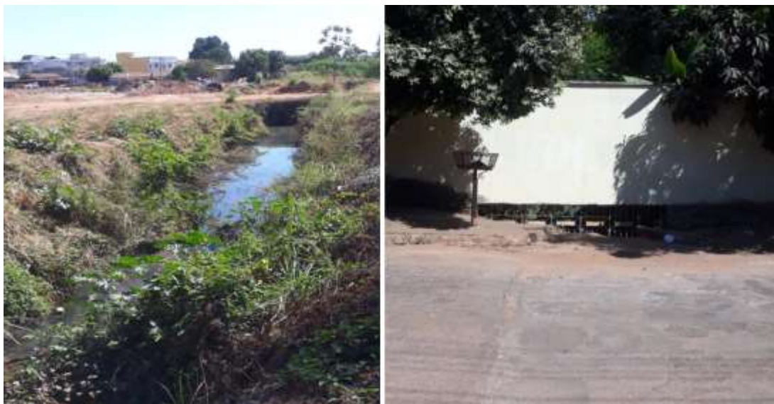
Figura 67: Dispositivos de drenagem pluvial urbana na Rua 10 (Esquerda) e Rua 07 (Direita)
