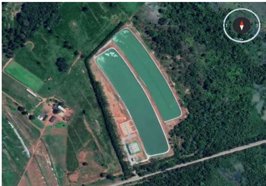
Figura 60: Estação de Tratamento de Esgoto (Lagoas Facultativa e Maturação)
