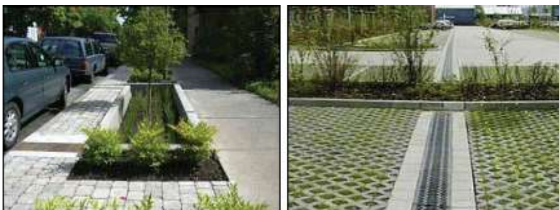
Figura 90: Trincheira de infiltração no passeio (Esquerda) e em estacionamento (Direita)
