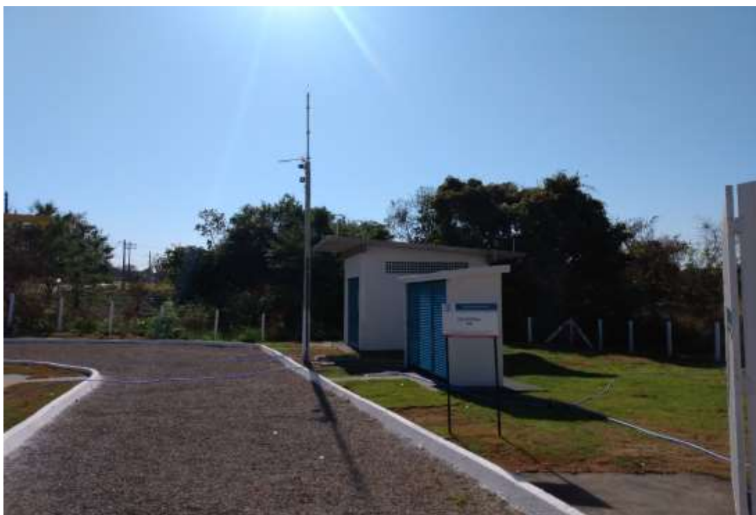
Figura 56: Estação Elevatória de Esgoto Sul (EEE Sul) (Fonte: DOMANI ENGENHARIA E OBRAS®, Set/2021)
